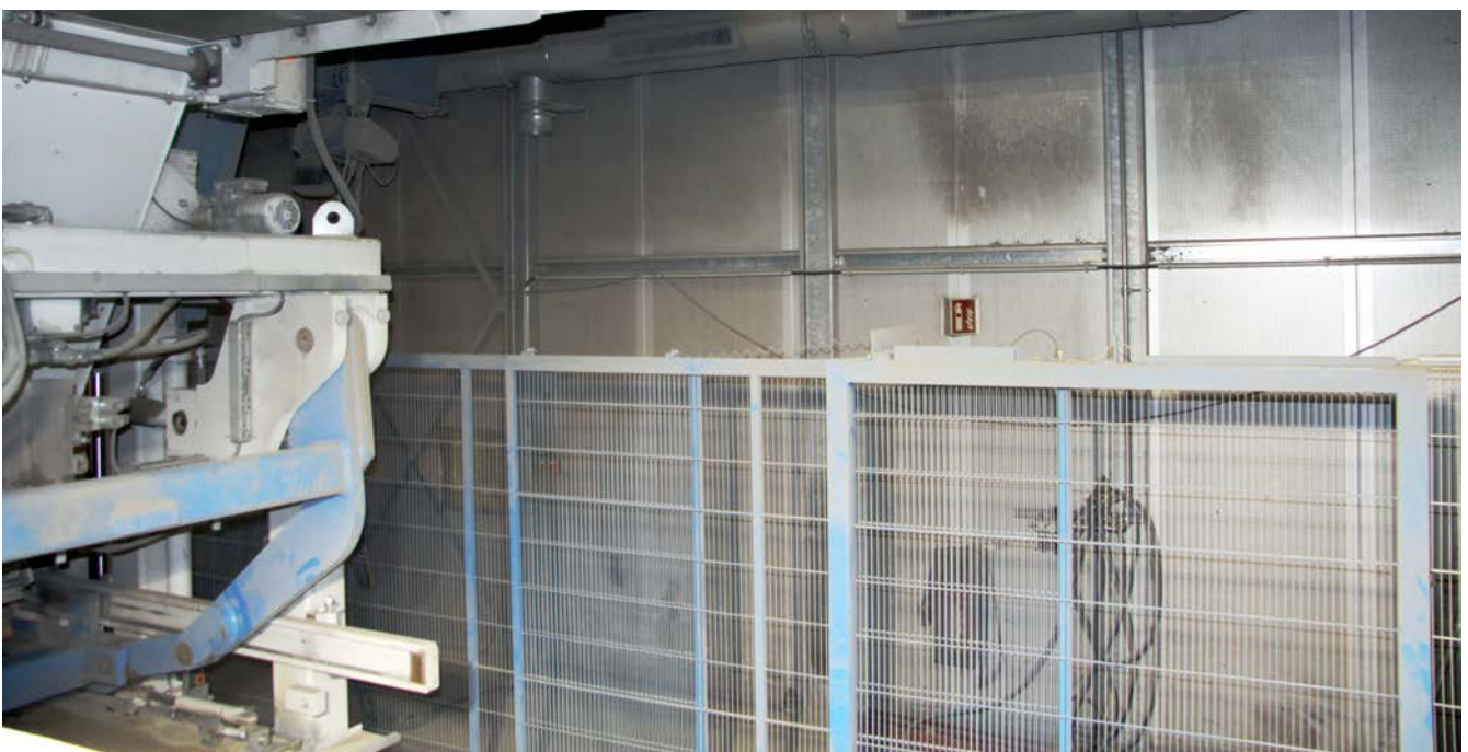
Abb. 60 Entstaubungstechnik im Bereich des Fertigers
