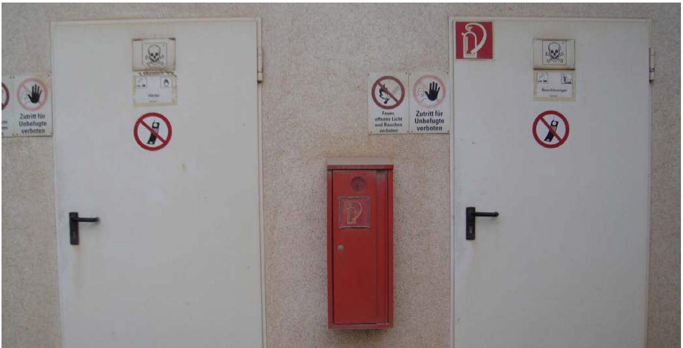
Abb. 88 getrennte Lagerung von Härter und Beschleuniger
