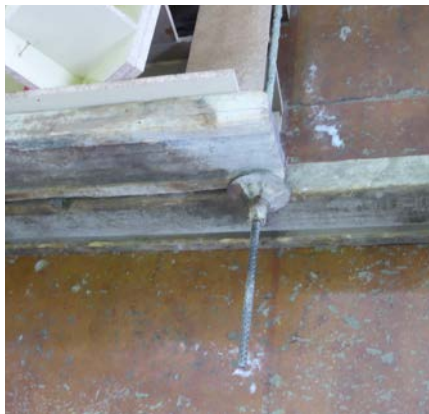
Abb. 22 Stolpergefahr durch überstehende Verbindungsmittel
