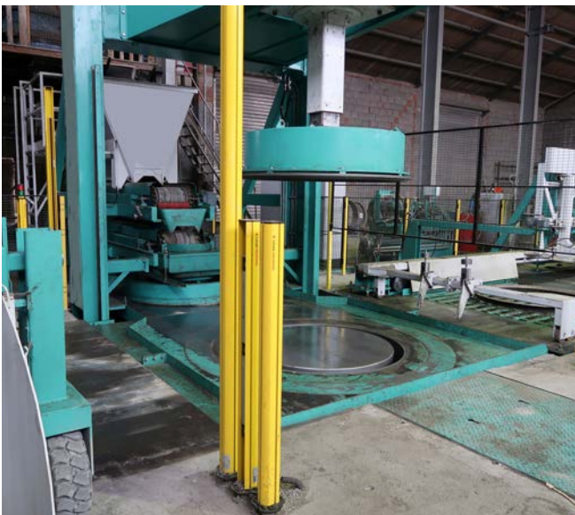
Abb. 48 regelgerechte Absicherung eines automatisierten Fertigungsprozesses
