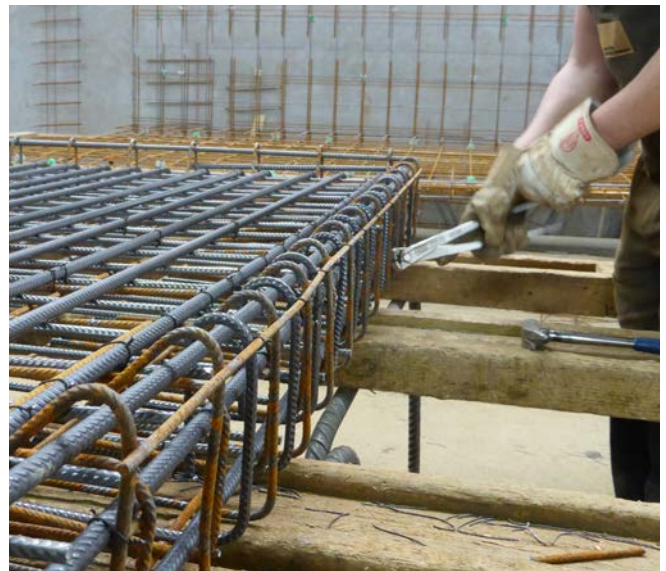
Abb. 25 ergonomisch günstige Arbeitshaltung bei Bewehrungsarbeiten
