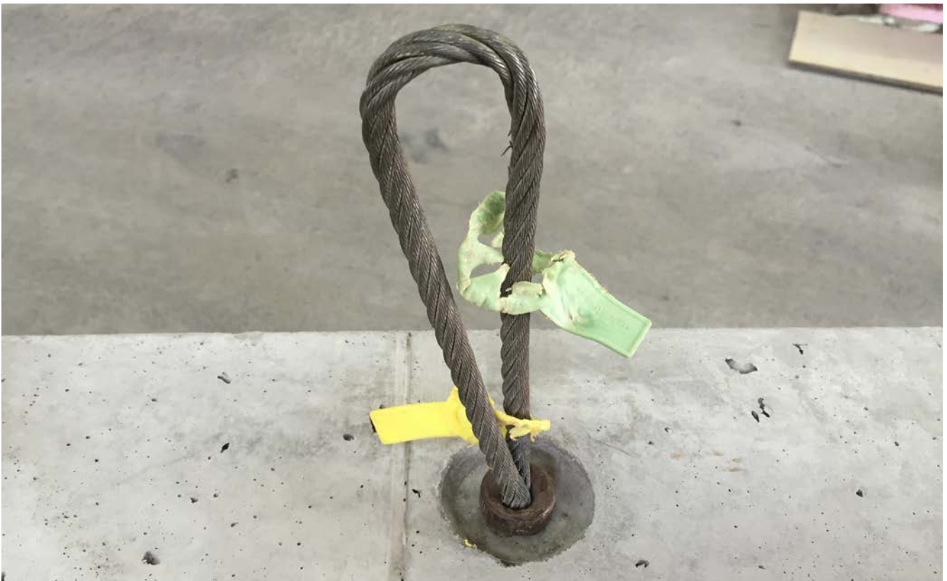
Abb. 33 Transportanker mit Lastaufnahmemittel
