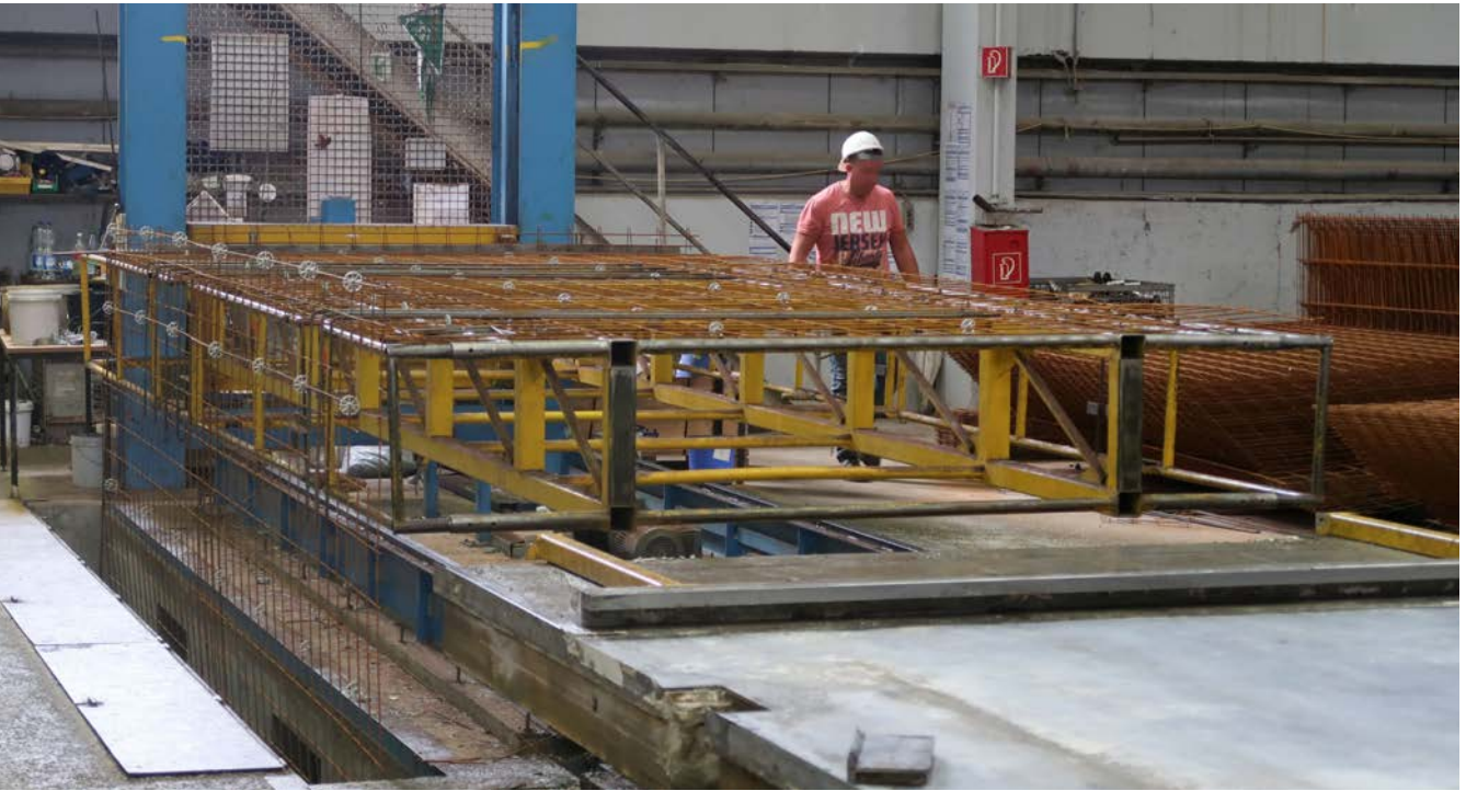
Abb. 82 Hebevorrichtung für den Bewehrungsbau zum ergonomischen Erstellen von Bewehrungskörpern
