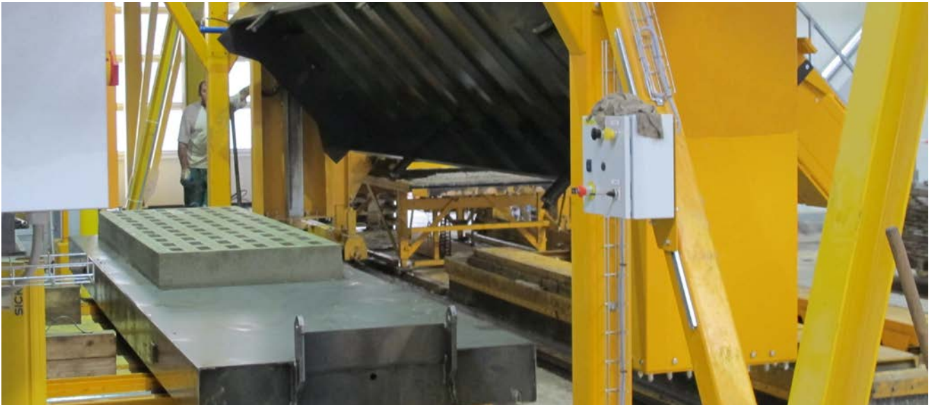
Abb. 100 Wenden des gefertigten Betonelementes
